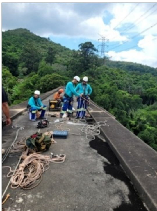
Equipe separando os equipamentos e deslocando até o local do vazamento
